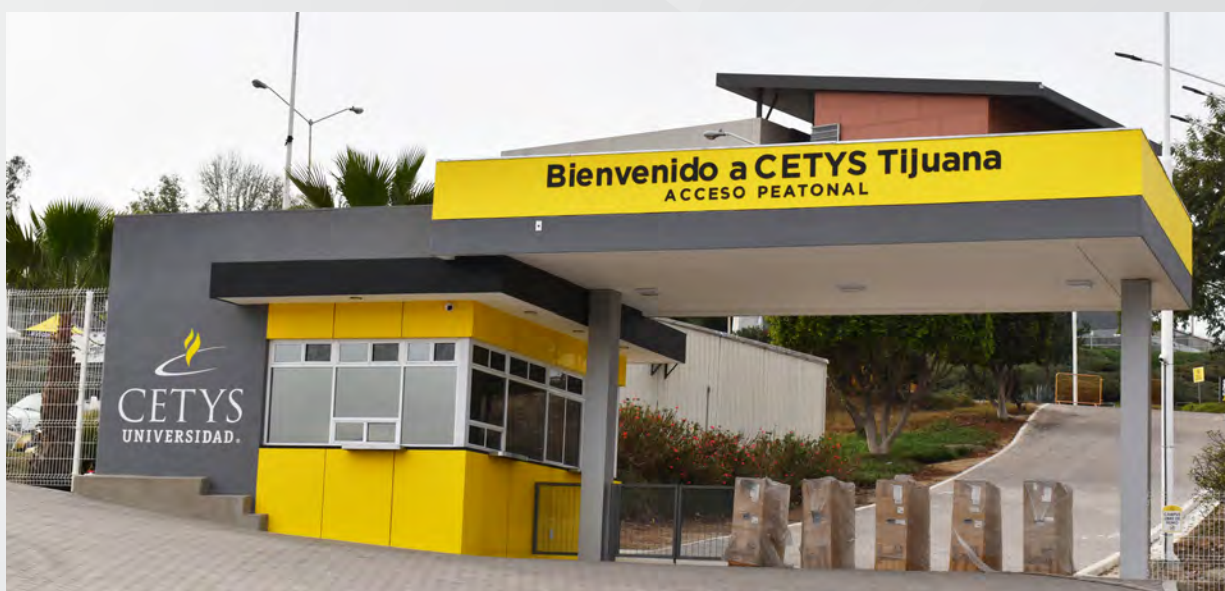
Caseta de acceso al campus.
