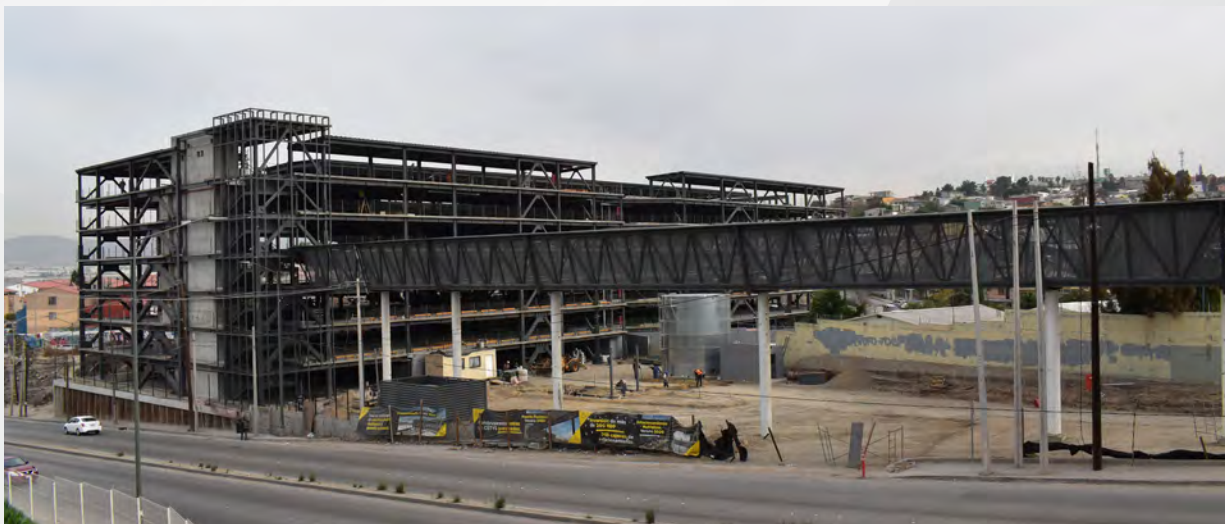
Avances del Estacionamiento Multinivel y Puente Peatonal.
